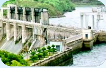
B R Project : Dam
