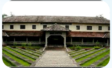
Kuppalli , Kuvempu's House
